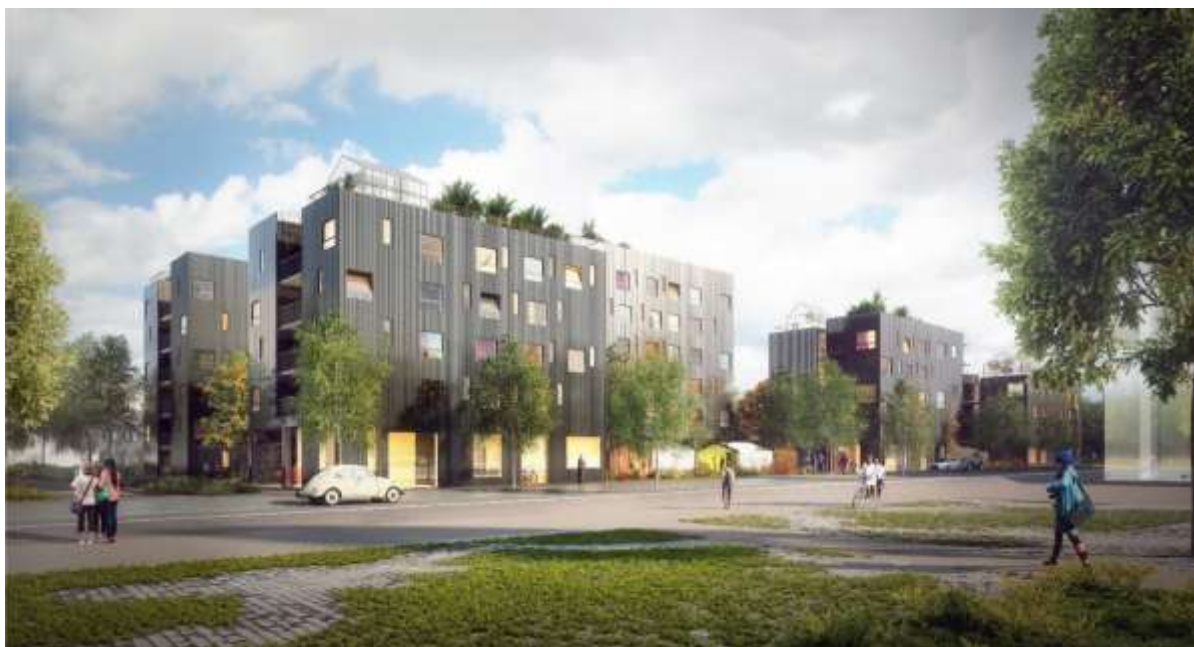
Projet de campus urbain de l'EPA Paris-Saclay (crédits EPA Paris-Saclay / Léon Grosse-Tank-Artelia-Atelier Altern Paysagistes)
