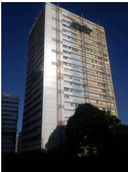
Tour Lenoir dans le 14 ème arrondissement de Paris après réhabilitation énergétique (crédits Ademe)
